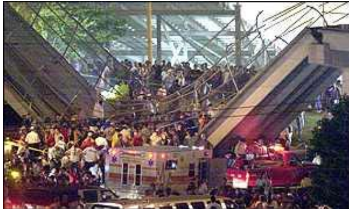
Figura 1.1 - Desabamento de uma passarela na Carolina do Norte/EUA
