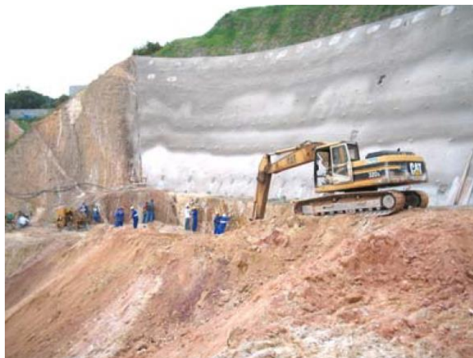
Figura 60 – Escavação mecânica para execução de solo grampeado, Niterói - RJ (Lima, 2007)
