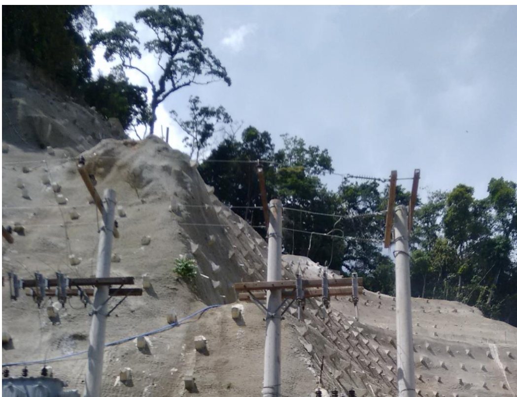
Figura 13 - Concreto Projetado - combinação de talude natural e escavado – Desemboque do novo túnel da nova subida de Petrópolis (arquivo pessoal 2015)
