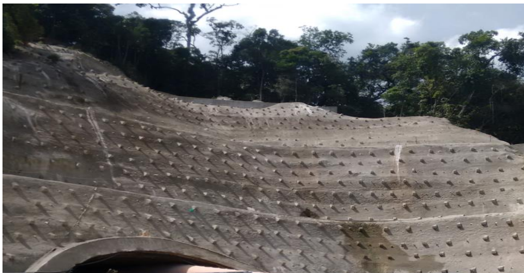
Figura 15 – Face em concreto projetado (arquivo pessoal 2015) – Nova Subida da Serra de Petropolis
