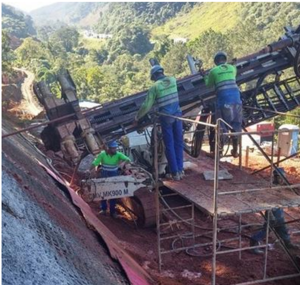
Figura 8 – Perfuração para execução de solo grampeado. Obra: Duplicação da Serra do Cafezal, Rodovia Regis Bittencourt, km 353
