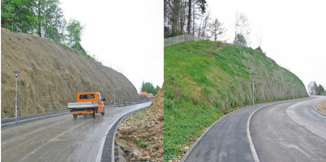
Figura 27 – Revestimento com tela TECCO de alta resistência – Geobrugg
