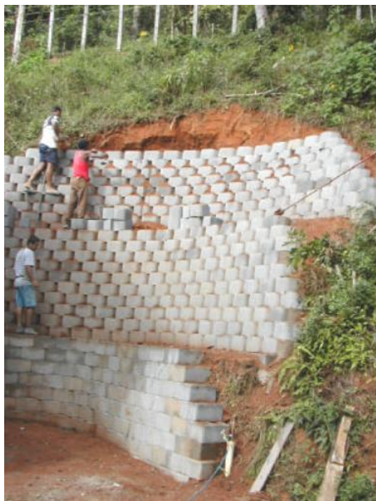
Figura 30 – Solo grampeado em Araras, Petrópolis – Muros Terrae
