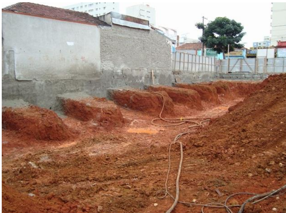
Figura 6 – Processo de escavação em bermas, execução de solo grampeado
