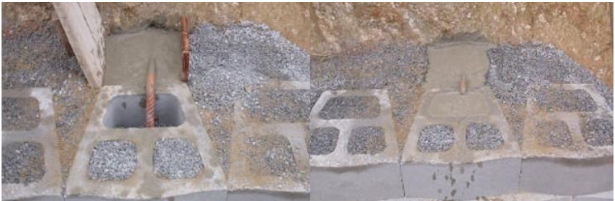
Figura 29 – Concretagem e solidarização do grampo no paramento - Muros Terrae
