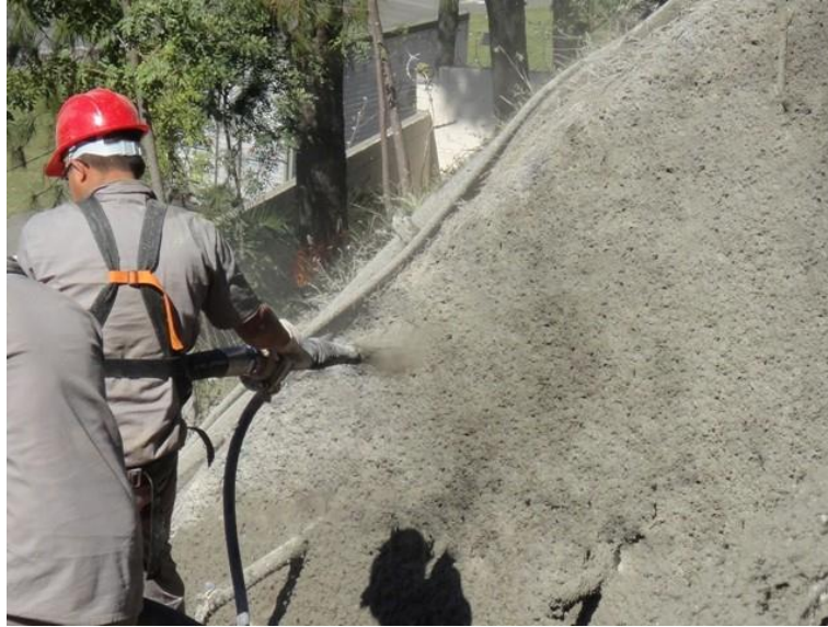
Figura 20 – Aplicação: concreto projetado com fibra metálica ( www.neomatex.com.brconcreto-fibras-polipropileno , 17/08/2015, 17:24)
