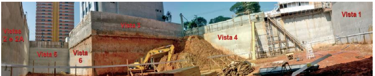
Figura 35 – Vista do término da execução da nova estabilização em solo grampeado (Souza et al, 2007)
