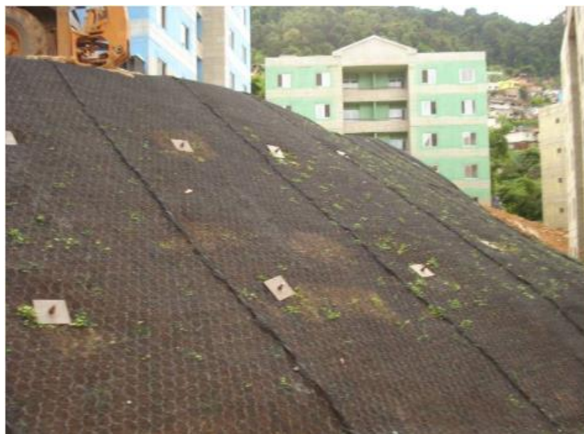
Figura 24 – Instalação da geomanta no talude em Angra dos Reis (Maccaferri, 2011)
