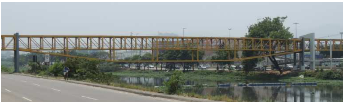
Figura 23 – Vista lateral da estrutura
