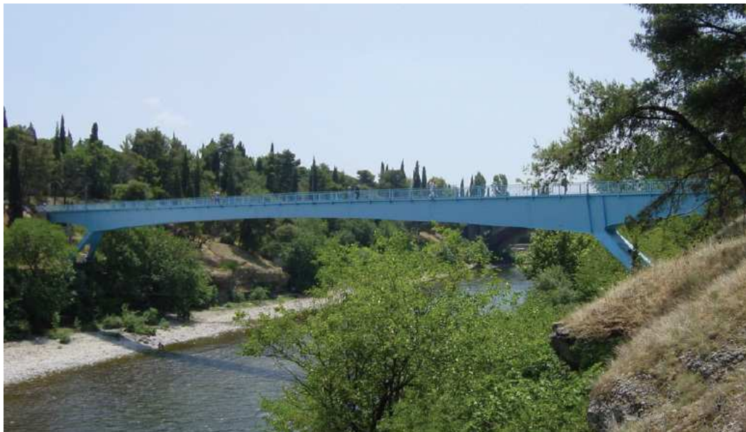
Figura 7 – Fotografia da passarela de Podgorica [8]
