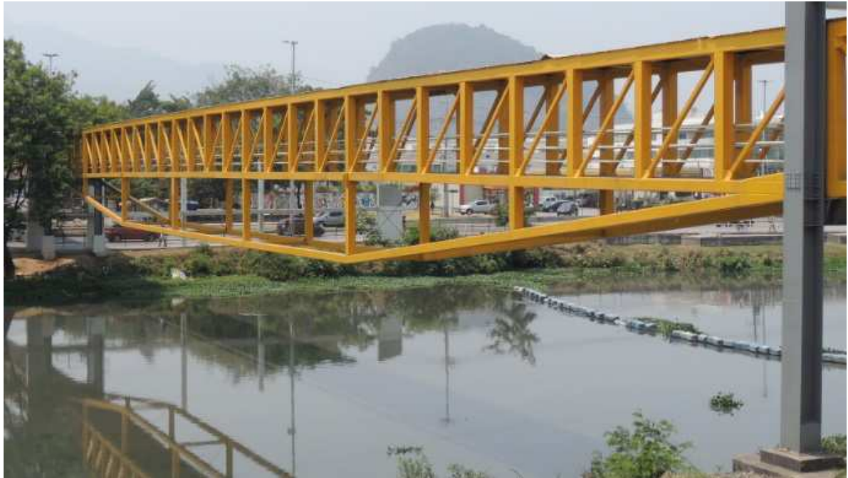
Figura 24 - Vista em perspectiva próxima à região dos apoios do vão central
