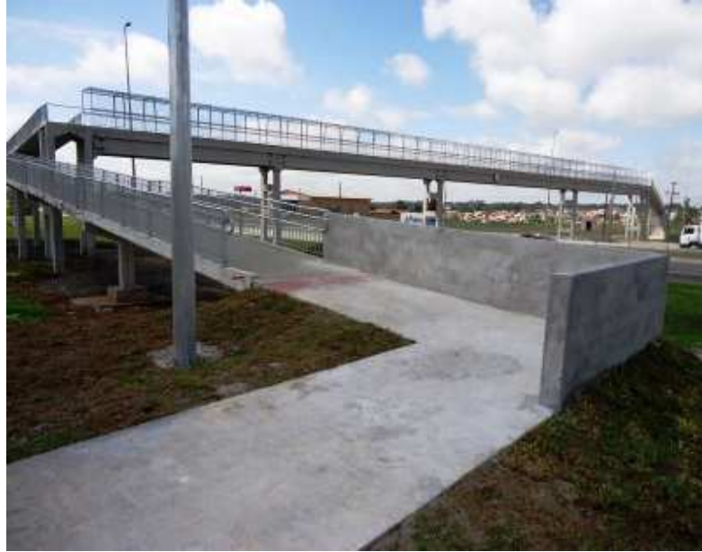
Figura 1 - Passarela com elementos pré-moldados [1]
