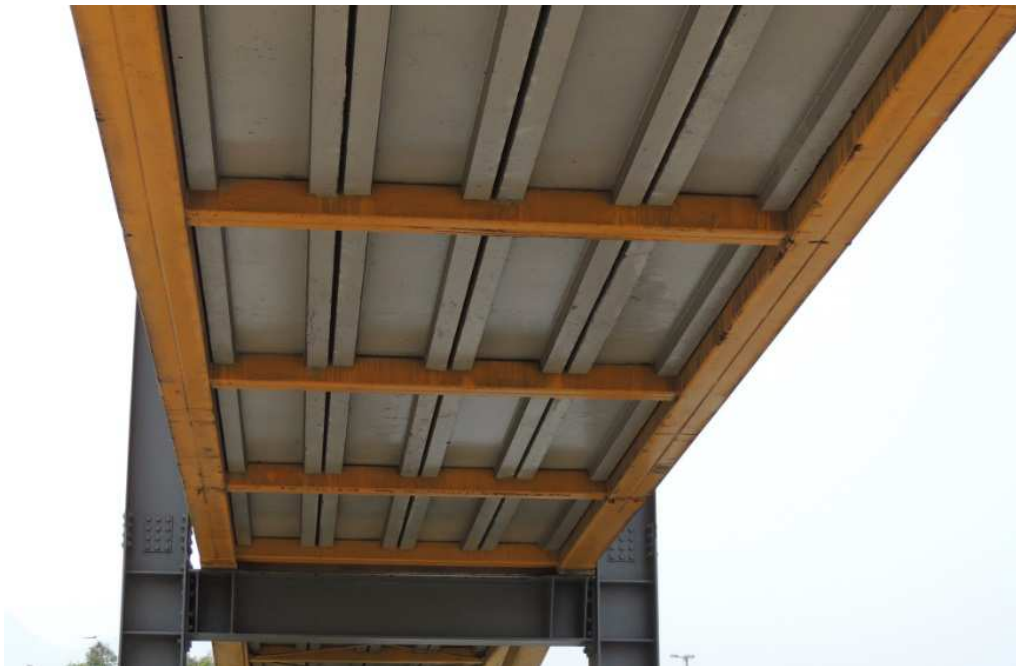
Figura 30 – Vista inferior dos elementos de laje pré-moldadas
