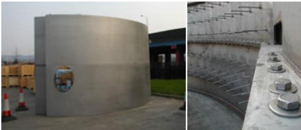
Figura 4 – Ponte *Stonecutters* – coluna mista em aço inoxidável e concreto [13]
