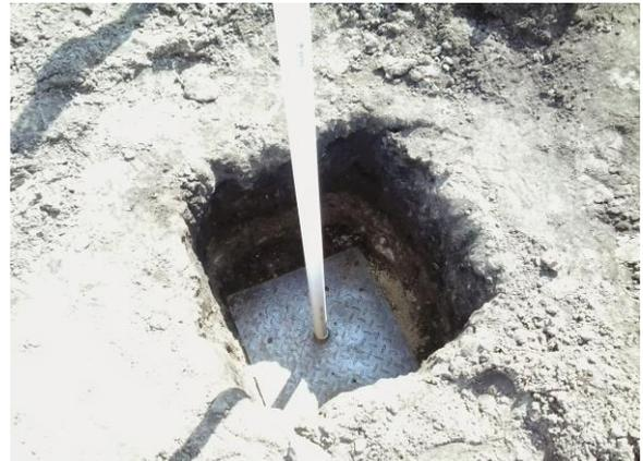
(b) Placa de recalque instalada.
