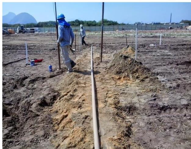
**Figura 45 – Instalação do tubo na base do aterro.**
