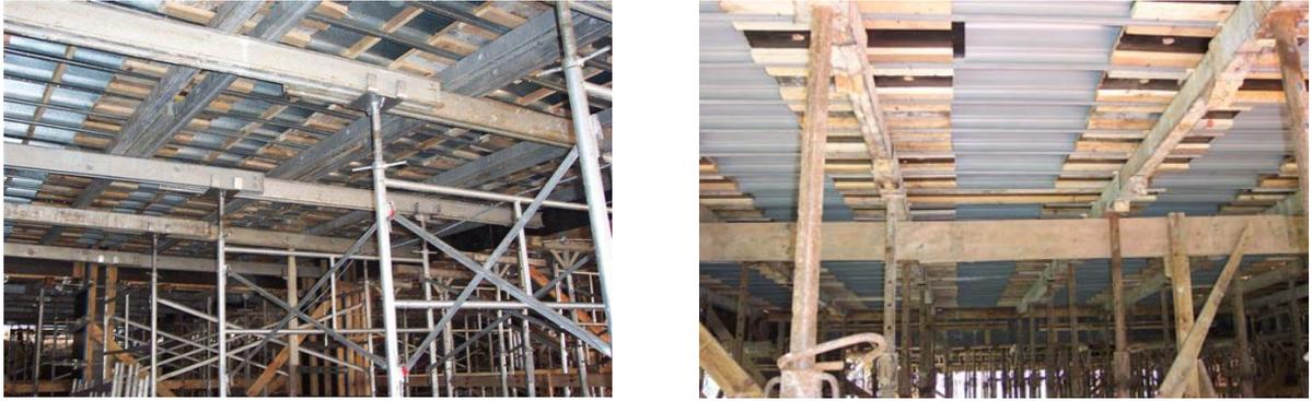
**Figura 3.4 – Esquema estrutural de escoramento**
