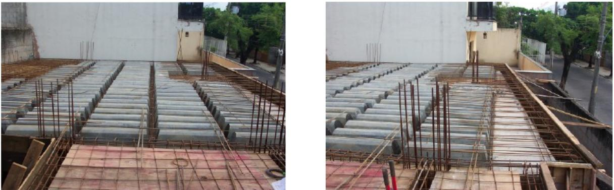
**Figura 3.5 – Sistema de laje nervurada com trechos de laje maciça**
