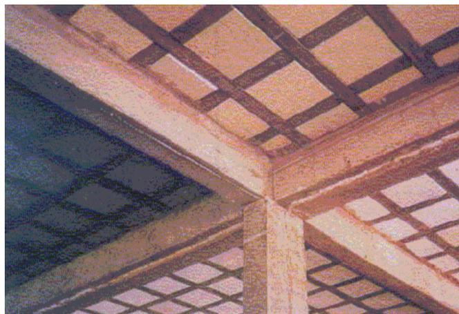
**Figura 1.2 – Laje nervurada bidirecional [2]**
