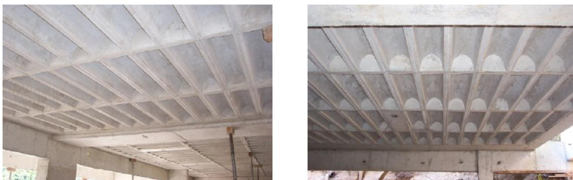
**Figura 3.1 – Lajes nervuradas do tipo REDUZCON**
