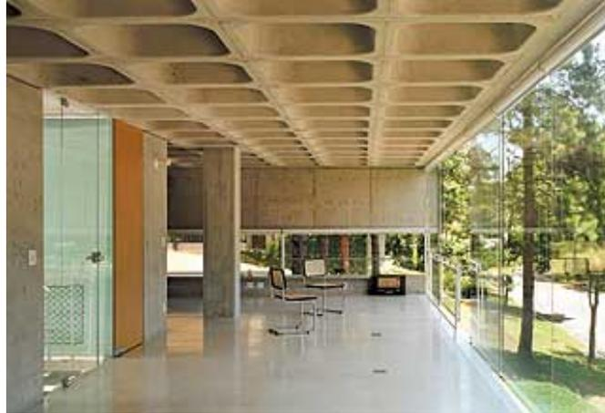
**Figura 1.1 - Laje nervurada de uma residência, Barueri-SP**
