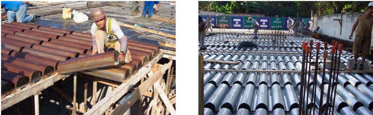
**Figura 3.3 – Formas semicilíndricas de lajes REDUZCON**
