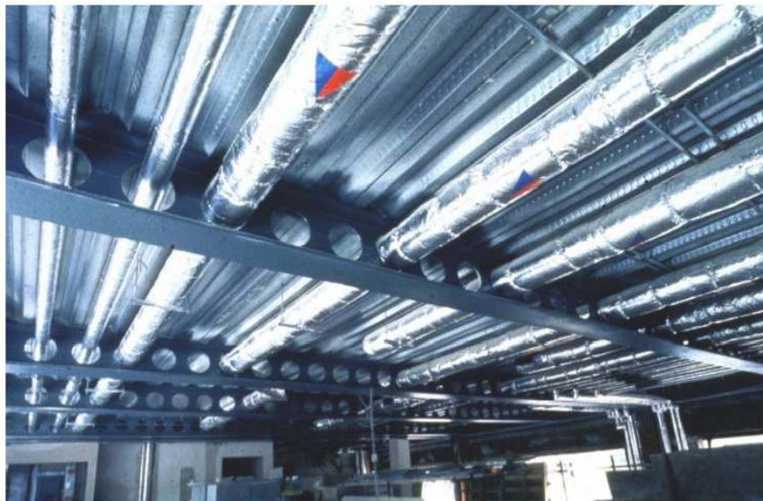
Figura 2.3 – Viga com furos regulares [14]
