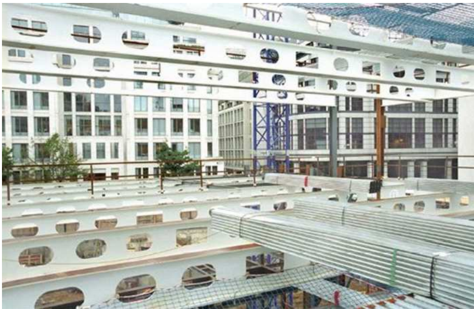
Figura 1.6 – Vigas com aberturas de formas variadas [14]
