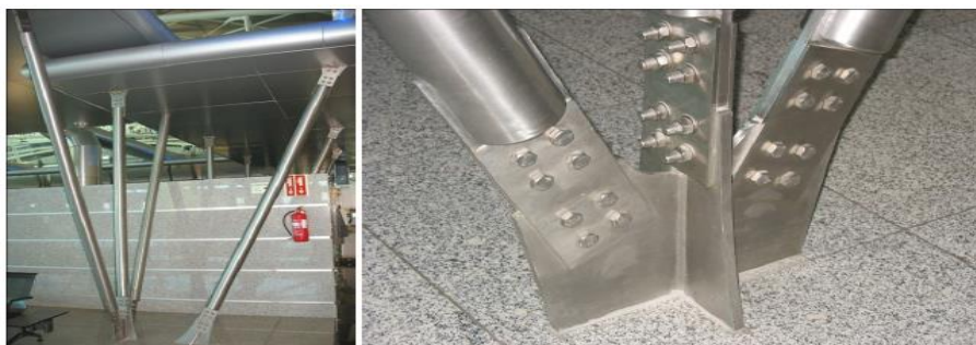
Figura 3 – Ligação aparafusada em estrutura de aço inoxidável [5].
