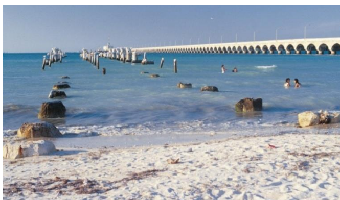
Figura 1 – Píer Progresso, México [2]
