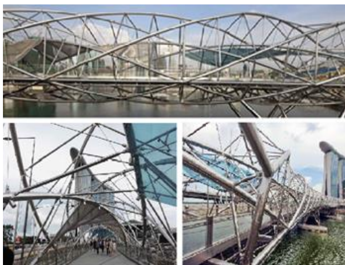
Figura 4 – Ponte Hélix, para pedestres, localizada em Cingapura [10].
