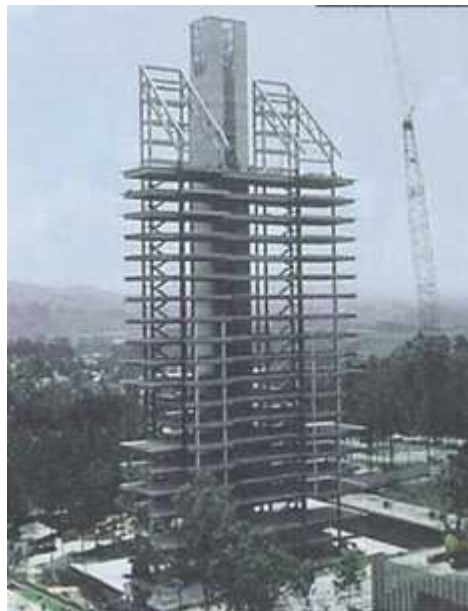
Figura 4. 1: Foto do esqueleto metálico do Ed. Alfacon, São Paulo
