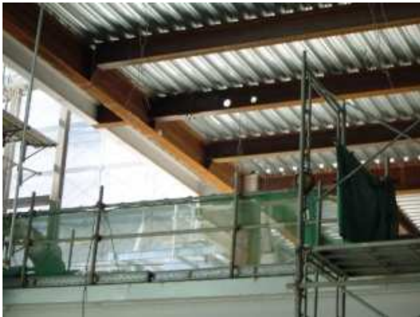
Figura 4. 23: Foto 2 de um canteiro de Obras em Kioto – Japão
