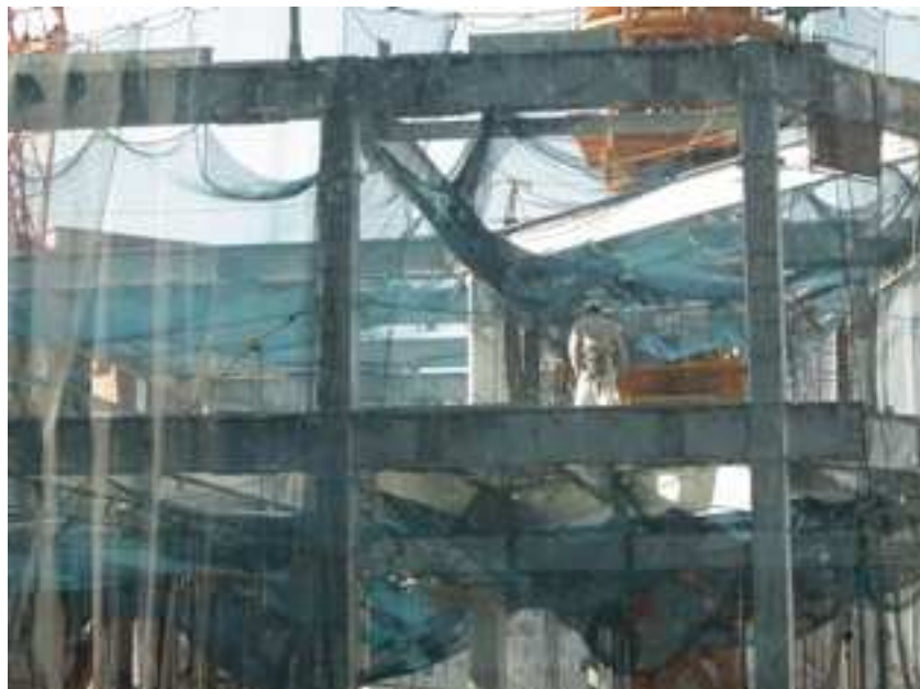
Figura 4. 13: Foto 1 de um canteiro de Obras em Kioto – Japão
