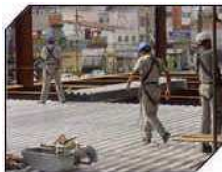
Figura 4. 5: Foto de obra em montagem de steel deck
