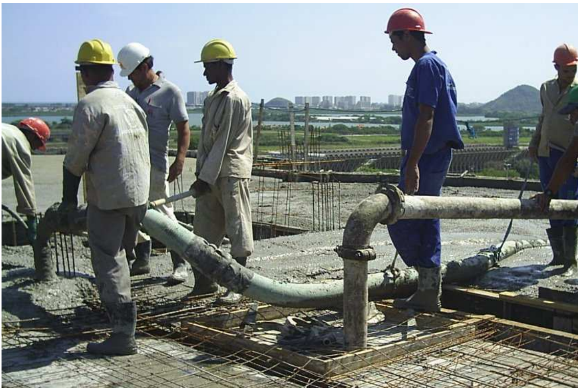
Figura 4. 12: Foto da execução da concretagem de uma laje
