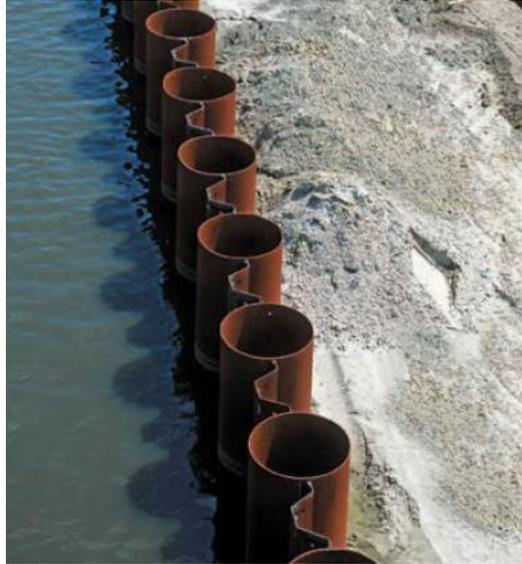
Figura 25 – Imagem de sistema de parede combinada de tubos de aço conectados a estacas-prancha.
