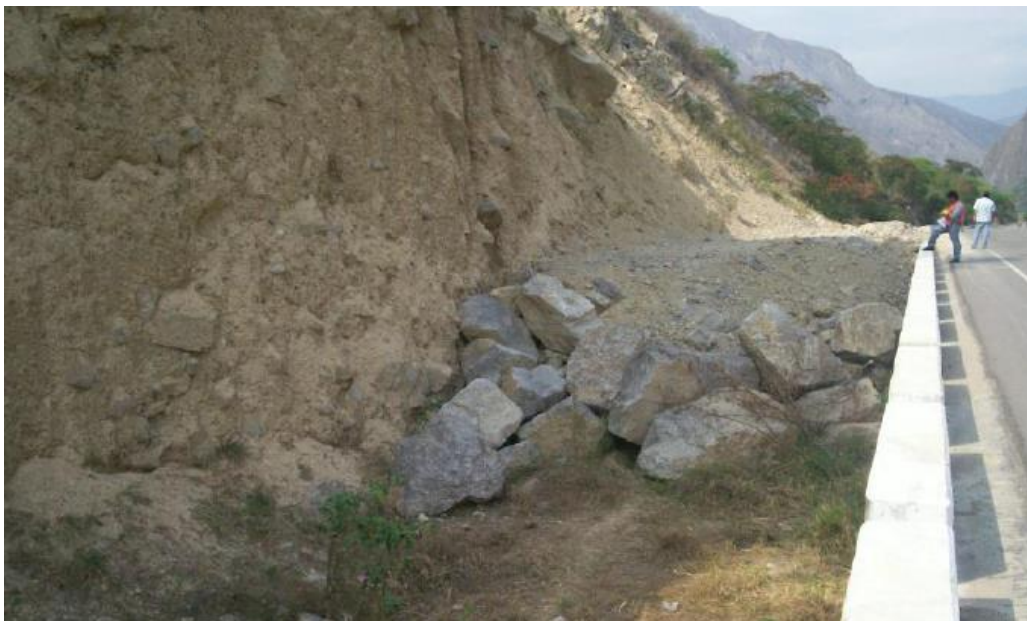
Figura 13 – Trincheira para coleta de bloco (Nunes, 2008)
