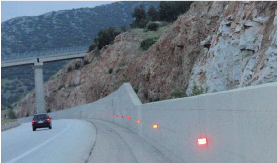
Figura 17 – Barreira rígida de impacto (Pantelidis e Kokkalin, 2011)
