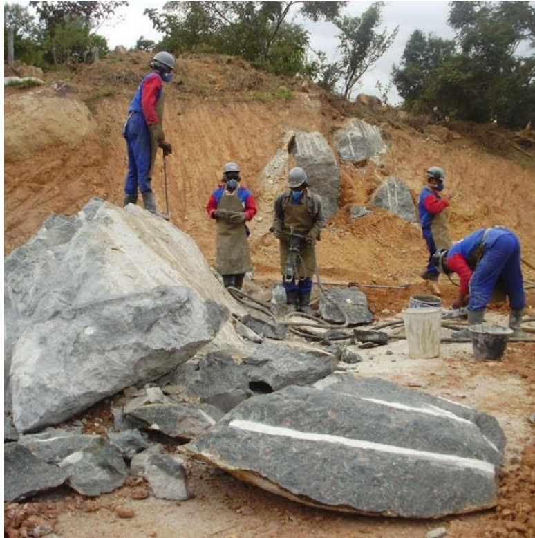
Figura 10 – Fragmentação de rocha para construção do gasoduto Paulínia – Jacutinga (MG) (DESMONTEC, 2009)
