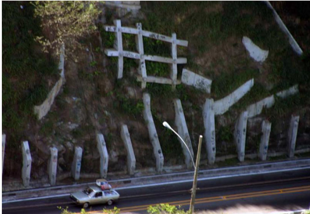
Figura 12 – Grelhas ancoradas e contrafortes (GEO-RIO (1999) apud Rocha (2009))
