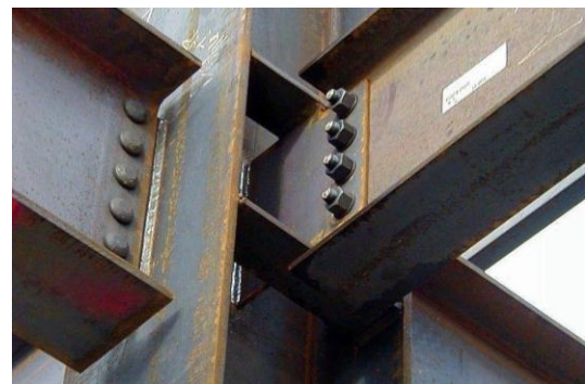
(b) Ligação aparafusada [14]
