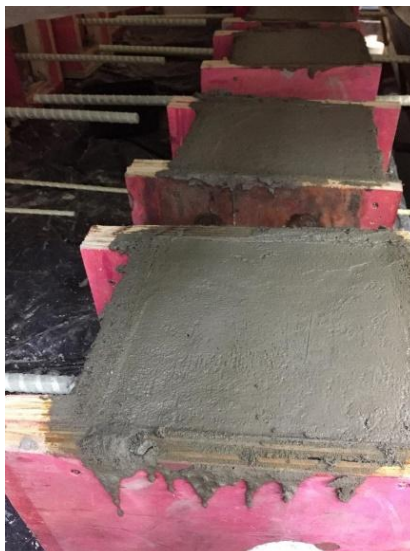
Figura 48- Corpos de prova concretados.
