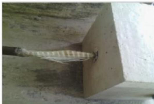
c) Ruptura da barra
