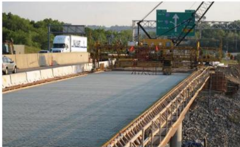
Figura 5- Tabuleiro de ponte construída com barras de GFRP em Kansas, EUA. (ACI 440.1R-15)
