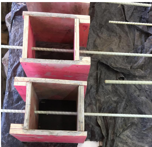
Figura 46- Forma para concretagem.
