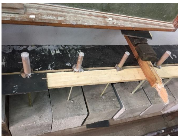
Figura 51- Ancoragem do tubo de pvc na extremidade da barra.
