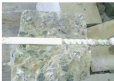
b) Fendilhamento do concreto
