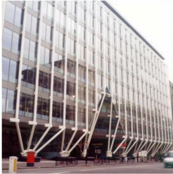
Figura 3 – Utilização de colunas CFT - Fleet Place House, Londres [9]
