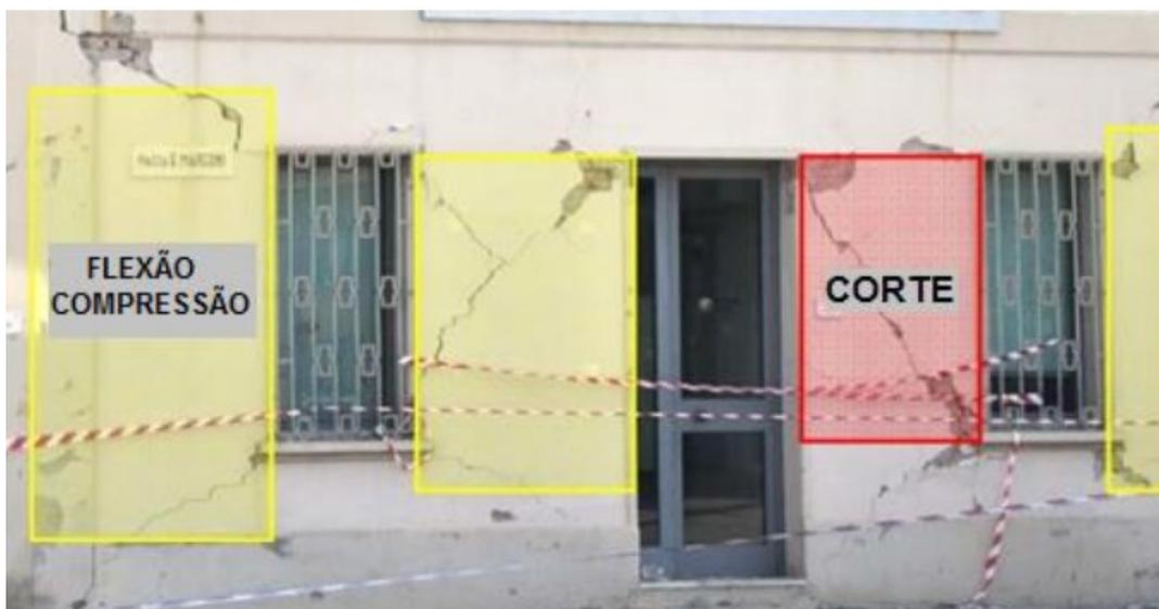
Figura 5 – Fissuras que ocorreram num edifício de alvenaria de tijolo, após um sismo ocorrido no norte de Itália, 2012. (Ferreira, 2014).
