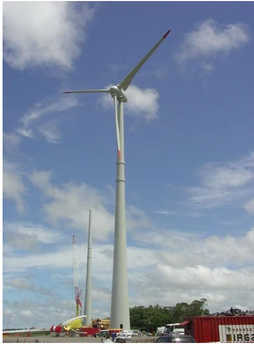
Figura 1.1 - Torre instalada no município de Osório (RS) [2]
