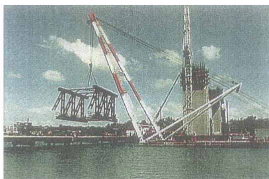
Figura 5.37 - Treliça de montagem sendo carregada pelo guindaste flutuante (ROTOLOONE, 1986).
