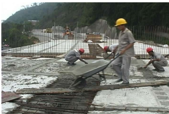
Figura 5.20 - Solidarização estrutural executada no local da obra.
