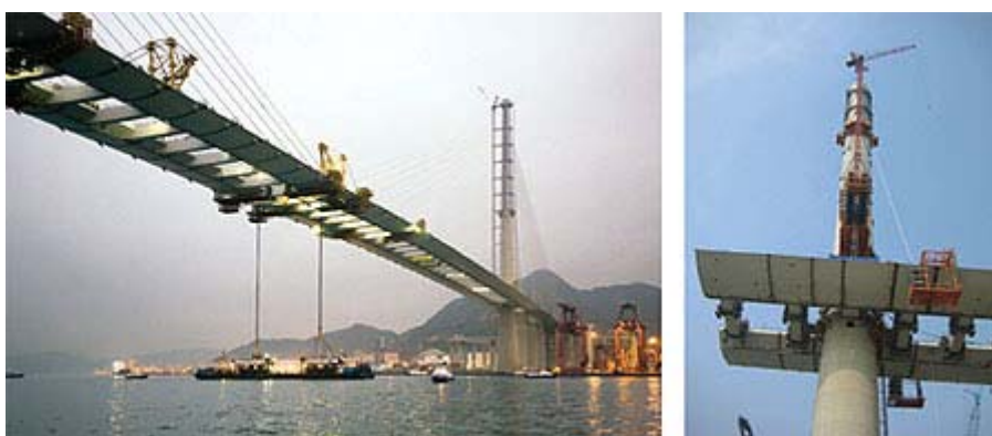
Figura 3.17 - Macaco hidráulico utilizado na montagem da Ponte Stonecutters Bridge, em Hong Kong, China. Disponível em: < http://www.revistatechne.com.br >.
