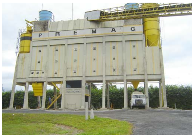
Figura 5.9 - Central de concreto
