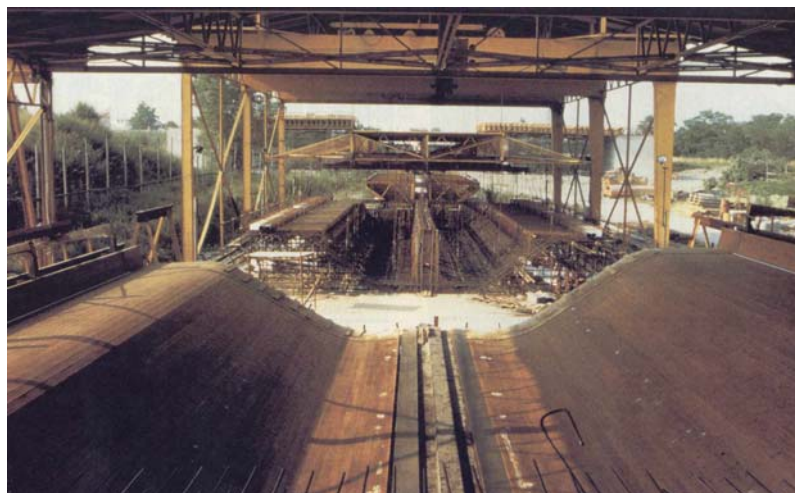
Figura 4.3 - Canteiro com áreas cobertas para montagem de gaiolas de armação e concretagem na ponte sobre o rio Serio, Itália (ROSIGNOLI, 1997 apud WAINBERG, 2002).
