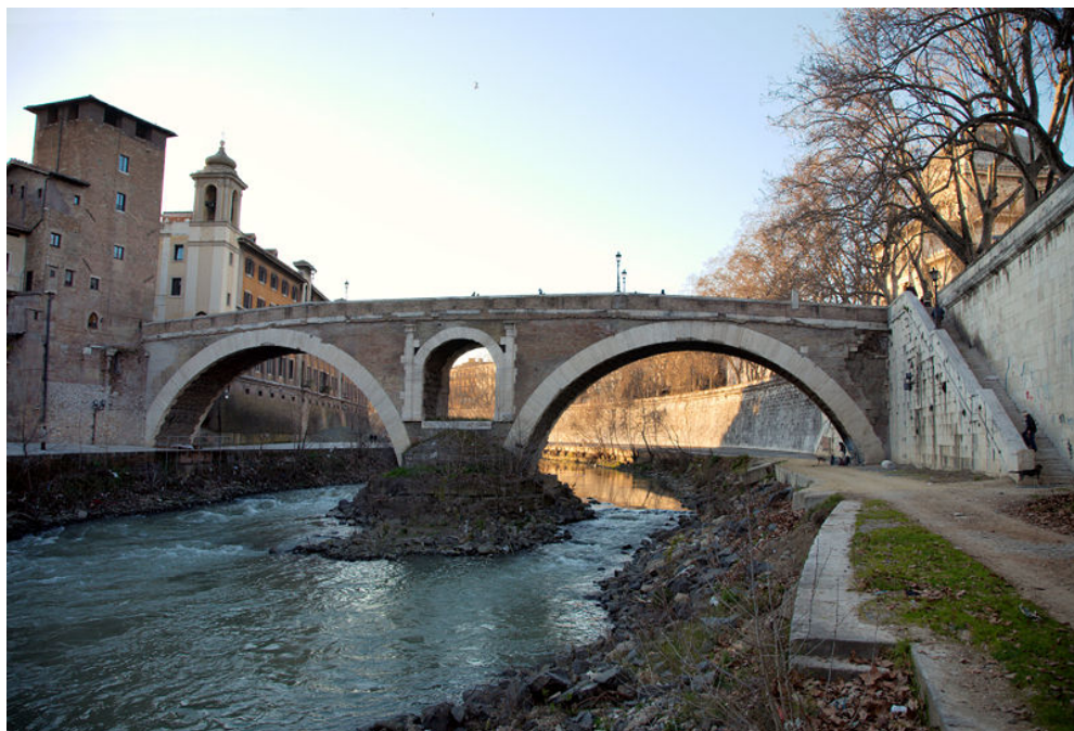
Figura 2.2 - Ponte Fabrício. Disponível em: < http://en.wikipedia.org/wiki/Pons_Fabrizius >
