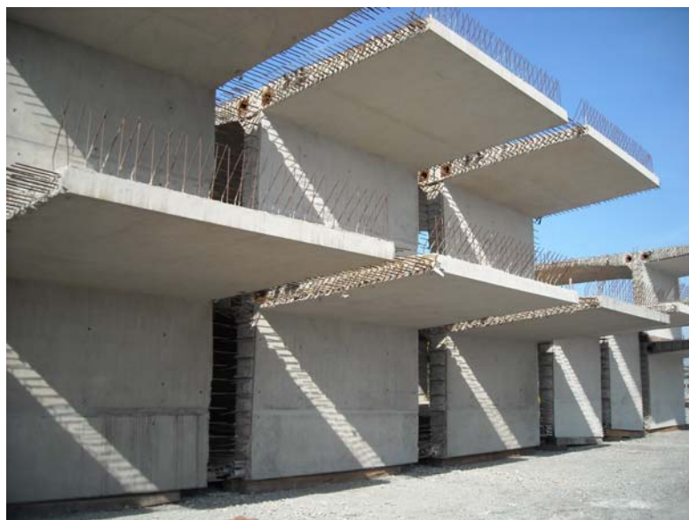
Figura 5.52 – Berço de estocagem das aduelas
