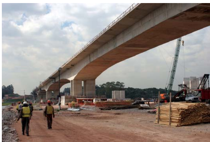
Figura 5.71 – Vão completo da ponte executado.
