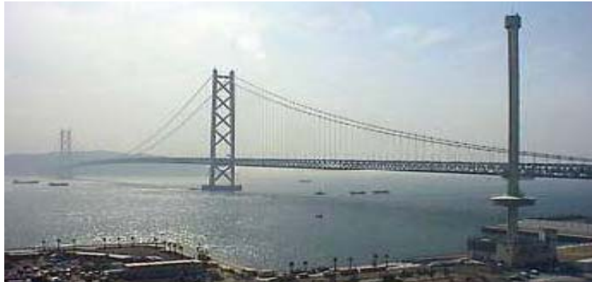
Figura 2.20 – Ponte Akashi Kaikyo. Disponível em: < http://www.engenhariacivil.wordpress.com >
