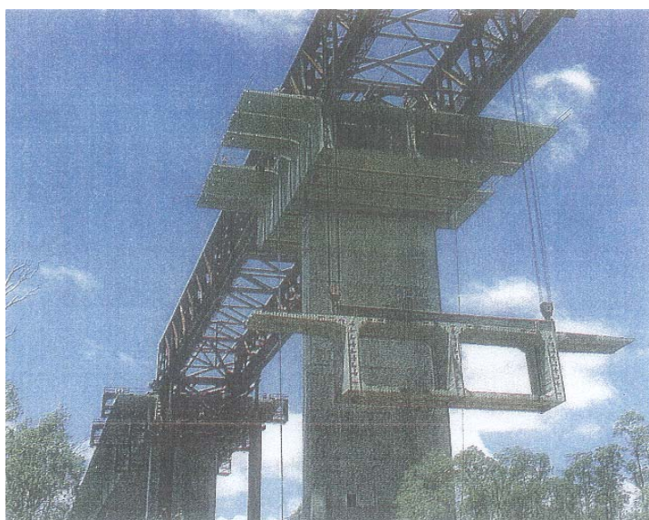
Figura 5.34 - Segmento pré-moldado da superestrutura do vão de acesso sendo levantado pela treliça de montagem (ROTOLONE, 1986).
