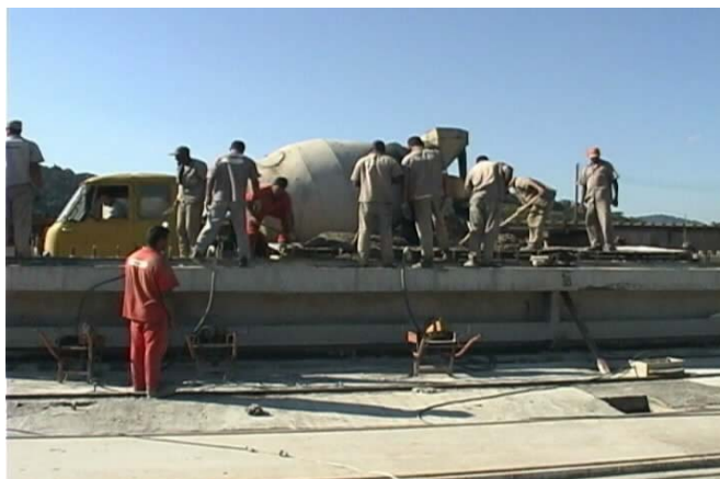
Figura 5.10 - Concretagem de uma viga com caminhão betoneira.
