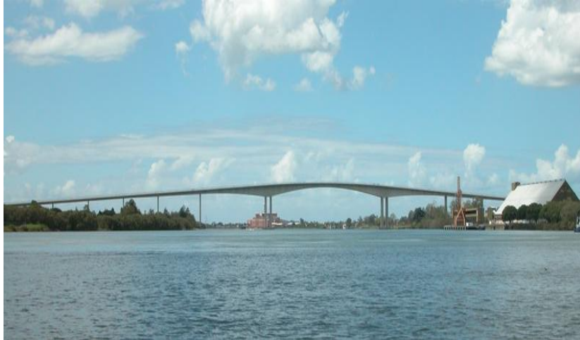
Figura 2.25 – Ponte Gateway, Brisbane. Disponível em: < http://www.en.structurae.de/structures >
