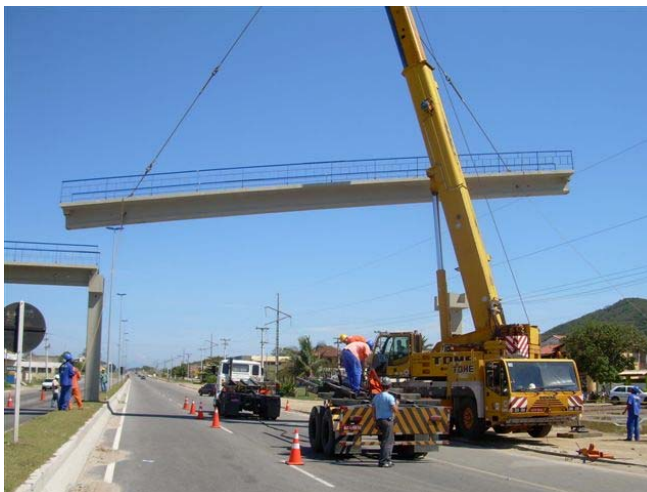
Figura 3.18 - Montagem de passarela para pedestres fabricada em usina de fabricação (cortesia Premag ® ).
