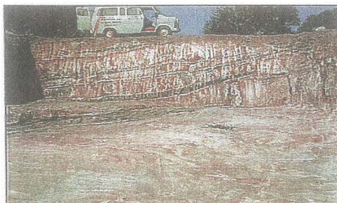
Figura 5.23 - Escavação para o Encontro A (HIGGINS; MATT, 1983).
