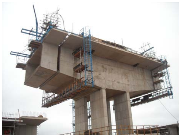
Figura 5.68 – Nivelamento e posicionamento final.
