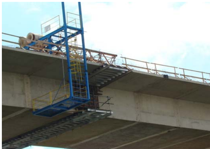
Figura 5.70 – Fechamento do vão central.
