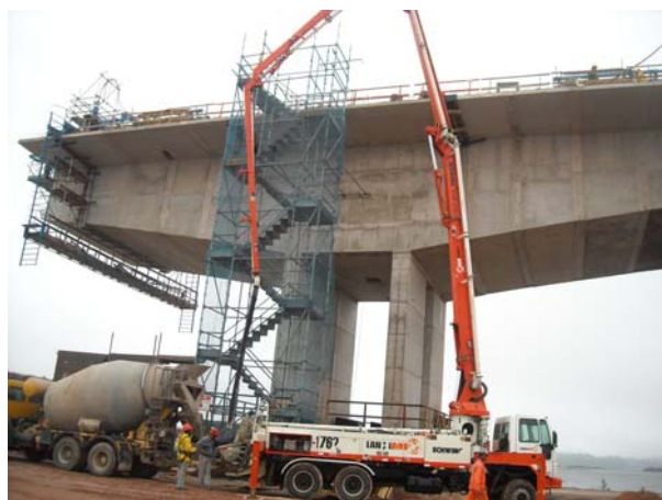
Figura 5.69 – Concretagem do anel de ligação.
