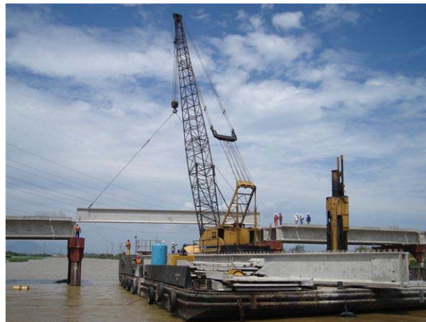
(c) Ponte sobre o canal São Fernando, Santa Cruz, Rio de Janeiro, RJ, montagem com guindaste sobre flutuante (cortesia da Premag®).
