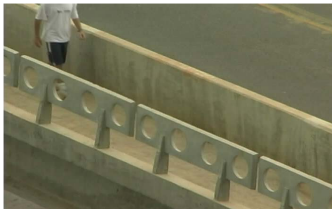
Figura 5.21 - Barreiras e guarda-corpos.
