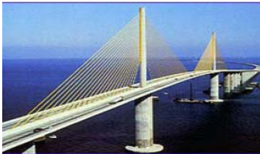
Figura 2.39 – Ponte Sunshine Skyway. Disponível em: < http:// www.pbs.org/wgbh/nova/bridge >
