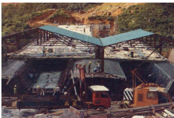
Figura 4.2 - Canteiro coberto para lançamento simultâneo de dois tabuleiros no anel viário de Tai Po, Hong Kong (ENGINEERING NEWS RECORD, 1984 apud WAINBERG, 2002).
