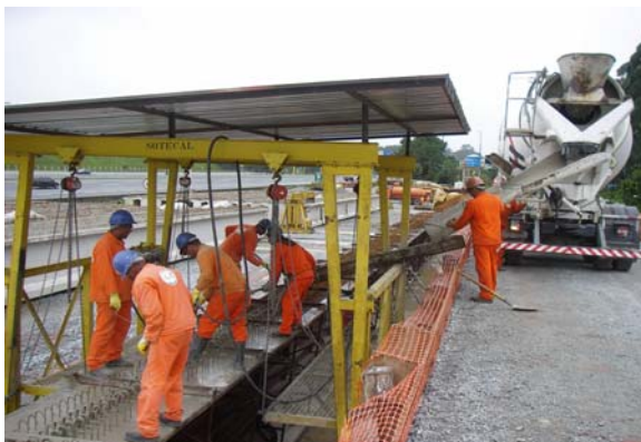
Figura 5.45 - Pátio de fabricação das vigas. Lançamento do concreto nas fôrmas por meio do caminhão betoneira, com utilização do pórtico manual sobre trilhos.
