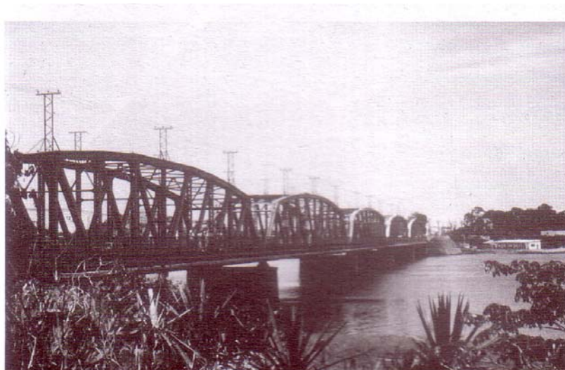
Figura 2.11 - Ponte Barra do Piraí. Disponível em: < http://www.wikipedia.org >
