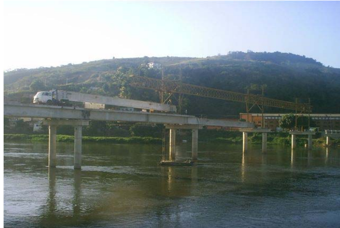
Figura 5.18 - Treliça de lançamento
