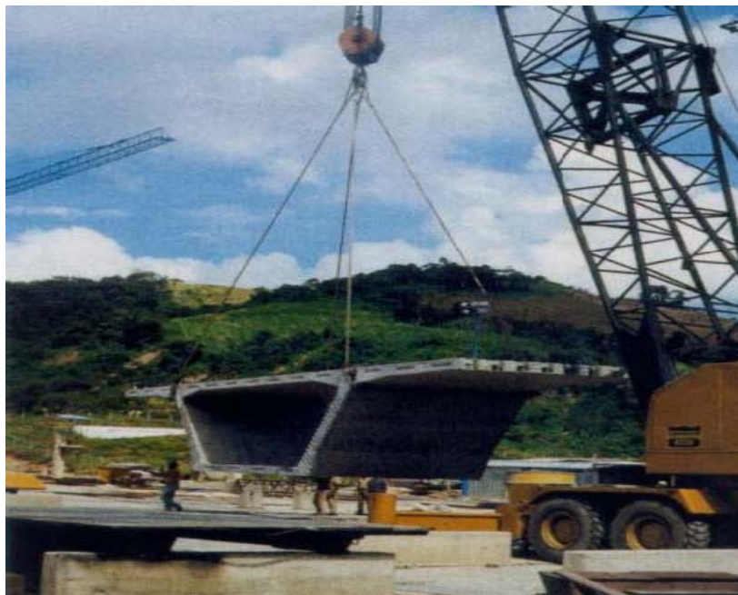
Figura 3.3 - Içamento de aduela pré-moldada (FIB, 2000 apud MATTOS, 2001).
