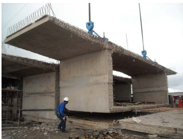
Figura 5.67 – Movimento inicial de descolamento do berço.
