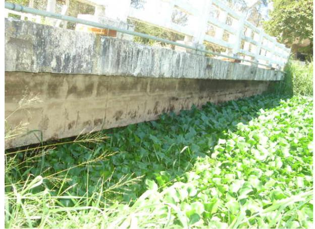
Foto 5.6 - Vista parcial da laje em balanço e viga longarina VL1 externa. Notar baixo gabarito vertical em relação ao canal.
