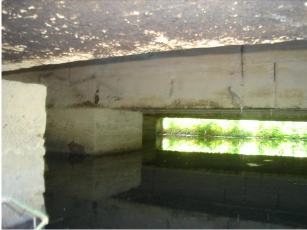
Foto 5.5 - Vista Parcial Inferior. Detalhe para os blocos do encontro. Notar pontos de corrosão da armadura de pele.
