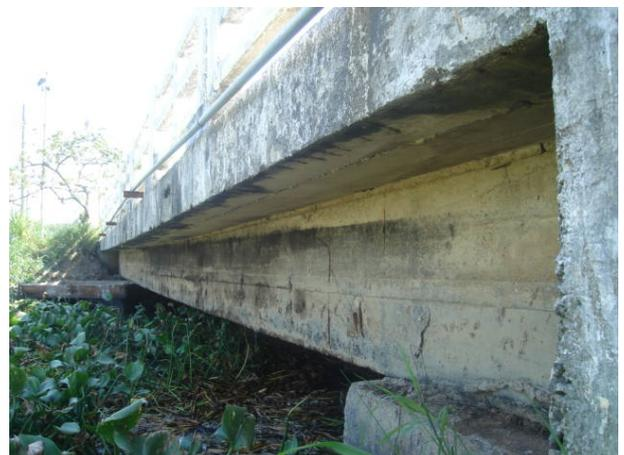
Foto 5.4 - Vista de laje em balanço e viga longarina VL4 externa.
