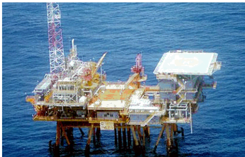
Figura 18 – Vista geral da plataforma de Merluza-1
