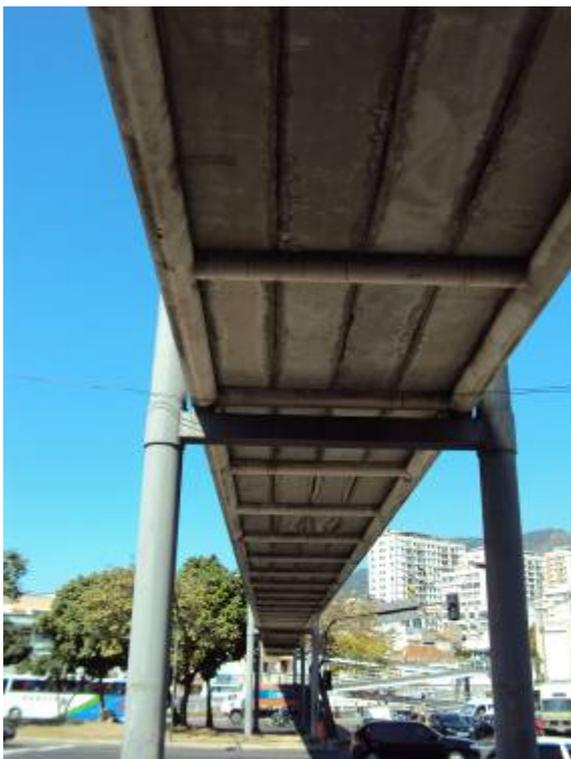
Figura 4.7– Detalhe dos pórticos e a vista inferior do tabuleiro da passarela.
