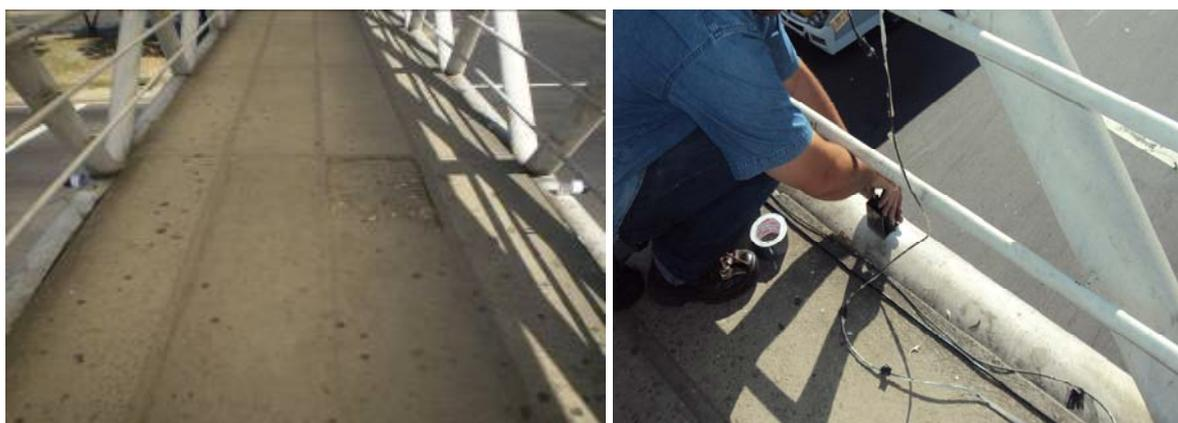
Figura 6.13 e 6.14 – Posicionamento dos sensores a ambos os lados do tabuleiro da passarela e detalhe da instalação dos sensores.
