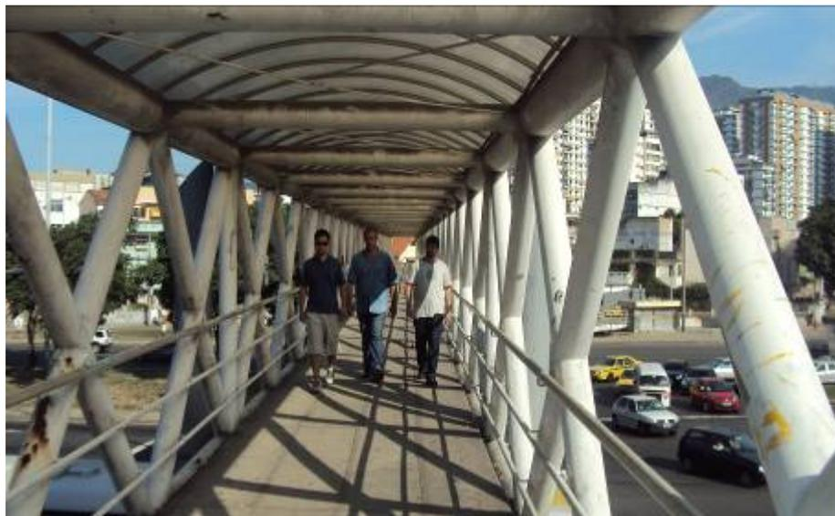
Figura 6.23 – Detalhe da excitação dinâmica induzida por três pessoas.
