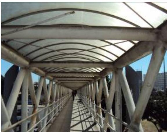
Figura 4.5 - Vista parcial do interior da passarela com detalhes das treliças.
