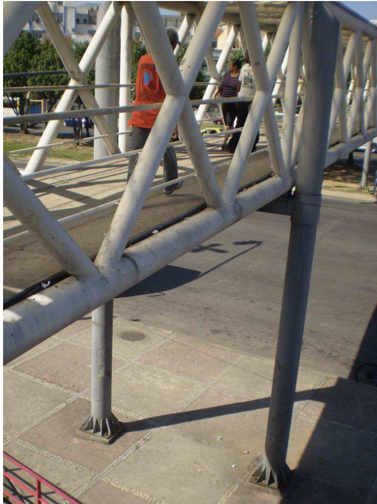
Figura 27 – Vista do pórtico da passarela
