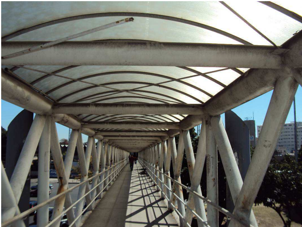
Figura 25 – Vista interna da passarela
