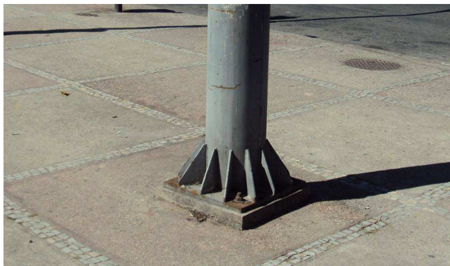
Figura 28 – Vista da base da passarela
