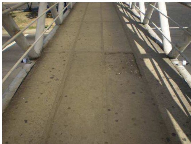
Figura 38 – Posicionamento dos Sensores em Ambos os Lados da Passarela [7].
