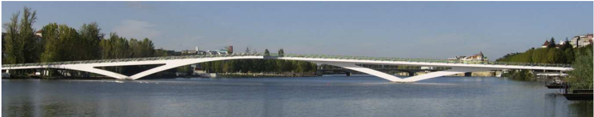
Figura 8 – Vista geral da passarela Pedro e Inês [5]
