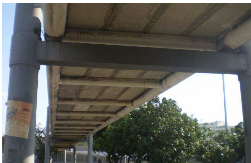
Figura 26 – Vista inferior da passarela
