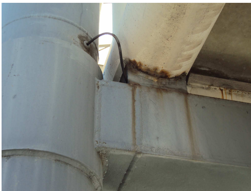
Figura 29 – Vista da ligação com neoprene
