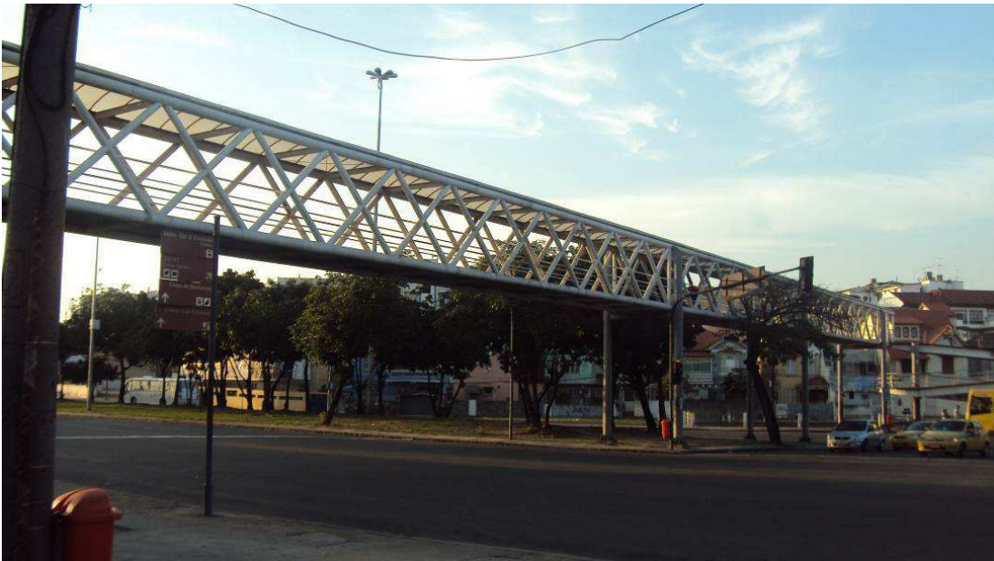
Figura 23 – Vista lateral oeste da passarela
