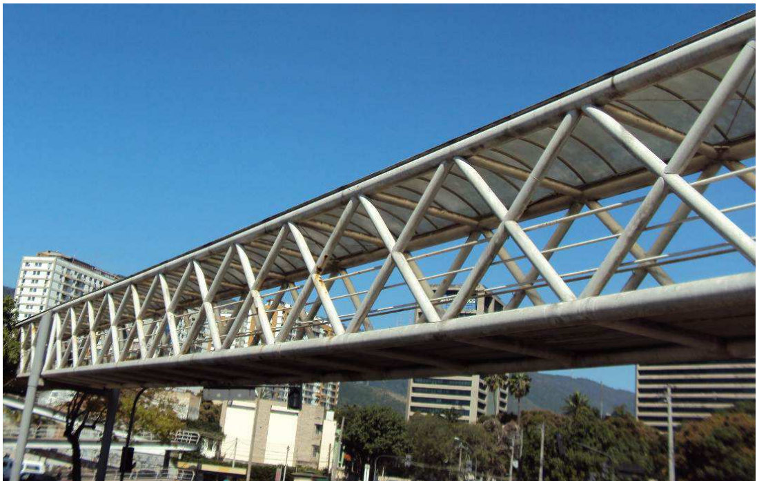
Figura 24 – Vista lateral leste da passarela
