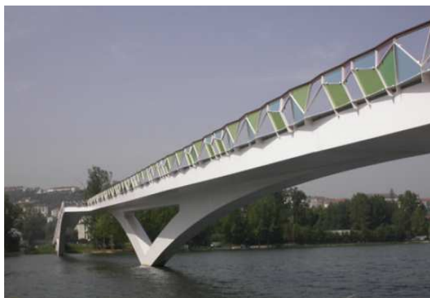
Figura 10 – Vista lateral da passarela Pedro e Inês [5]
