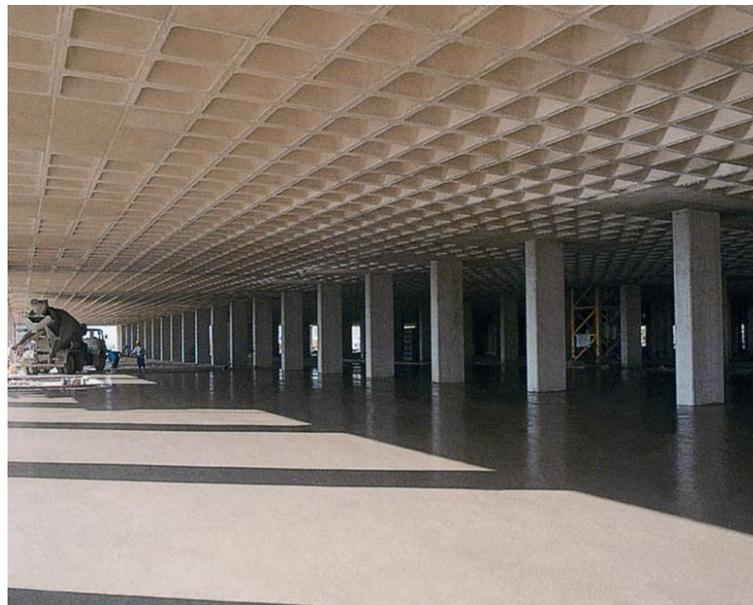
**Figura 3 – Arranjo físico de lajes nervuradas [11]**
