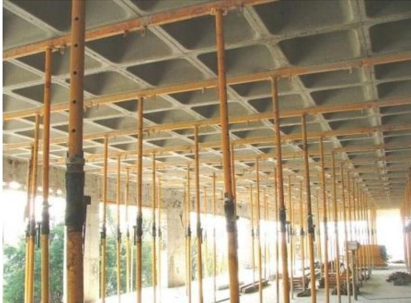
**Figura 2 – Escoramento de lajes nervuradas [6]**
