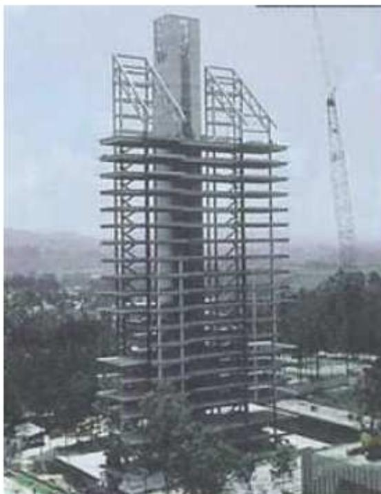
**Figura 35: Foto do esqueleto metálico do Ed. Alfacon, São Paulo. Fonte: Oliveira (2007)**
