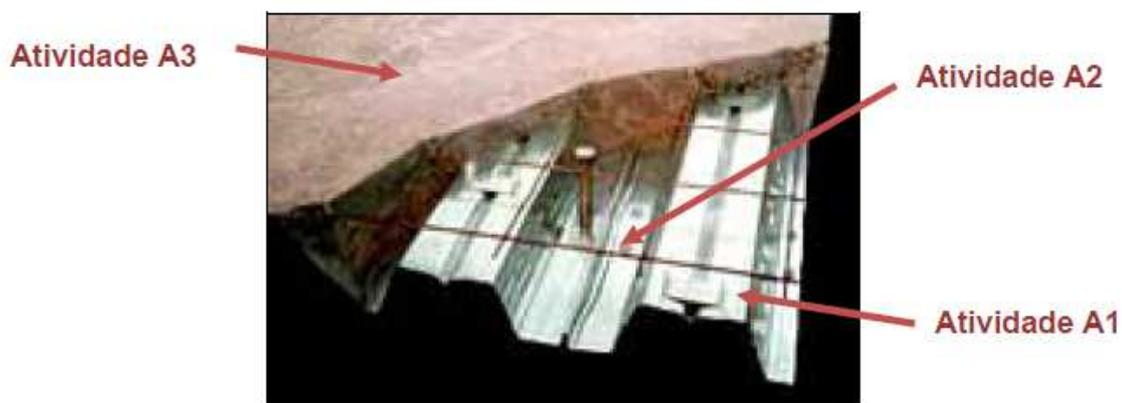
Figura 37: Corte transversal da estrutura utilizada na montagem do *steel deck*. Fonte: Azevedo (2010)
