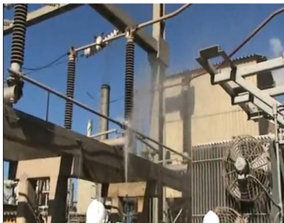
a) Lavagem de isolador
