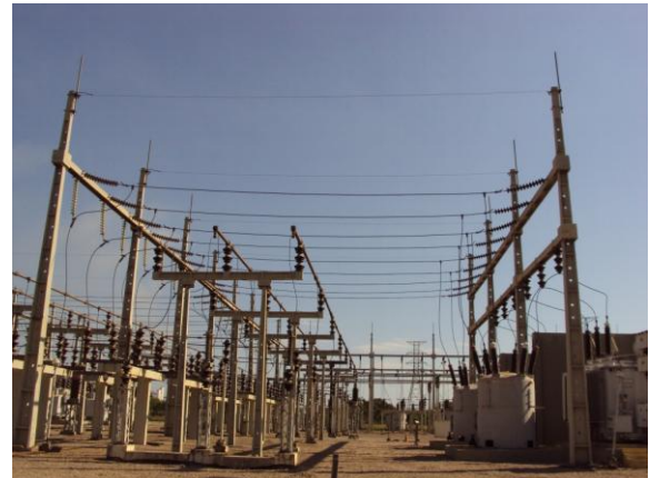
b) Concreto pré-moldado vibrado
