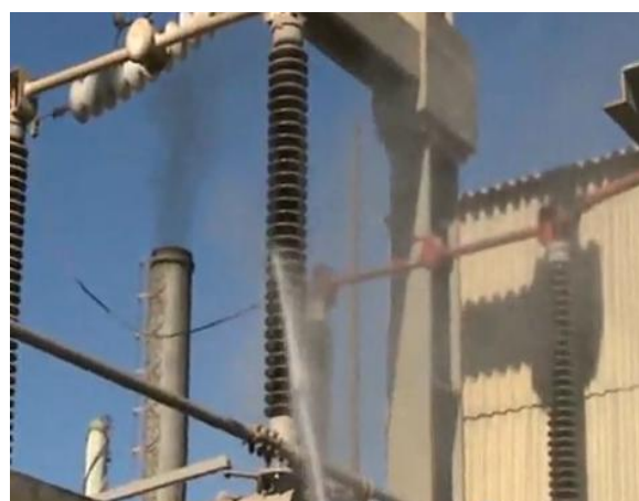
b) Lavagem de isolador
