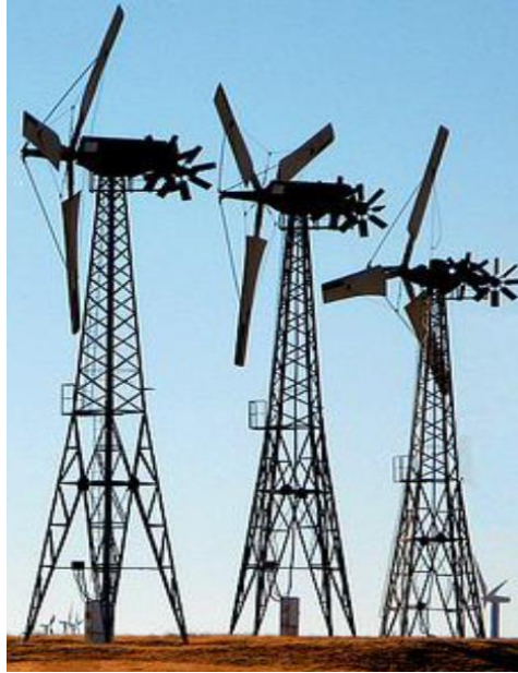
Figura 8 – Torre do tipo treliça [11].
