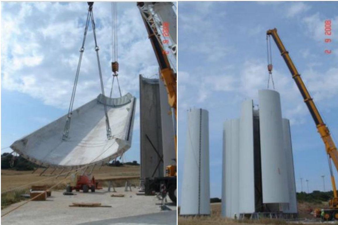
Figura 10 – Montagem de torre pré-fabricada de concreto [11].
