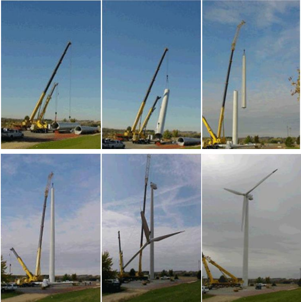
Figura 11 – Procedimentos de montagem dos segmentos de uma torre eólica tubular [11].
