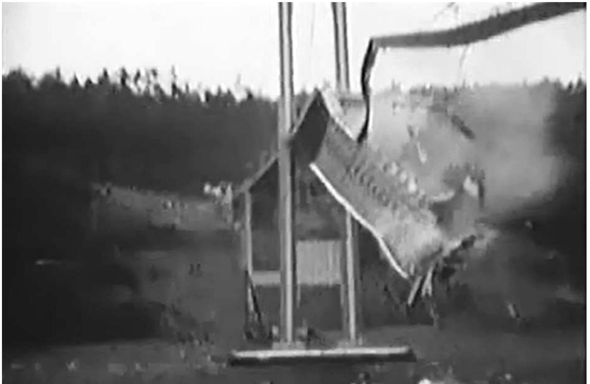
**Figura 3 - Colapso da estrutura provocado pelo fenômeno da fadiga.**
