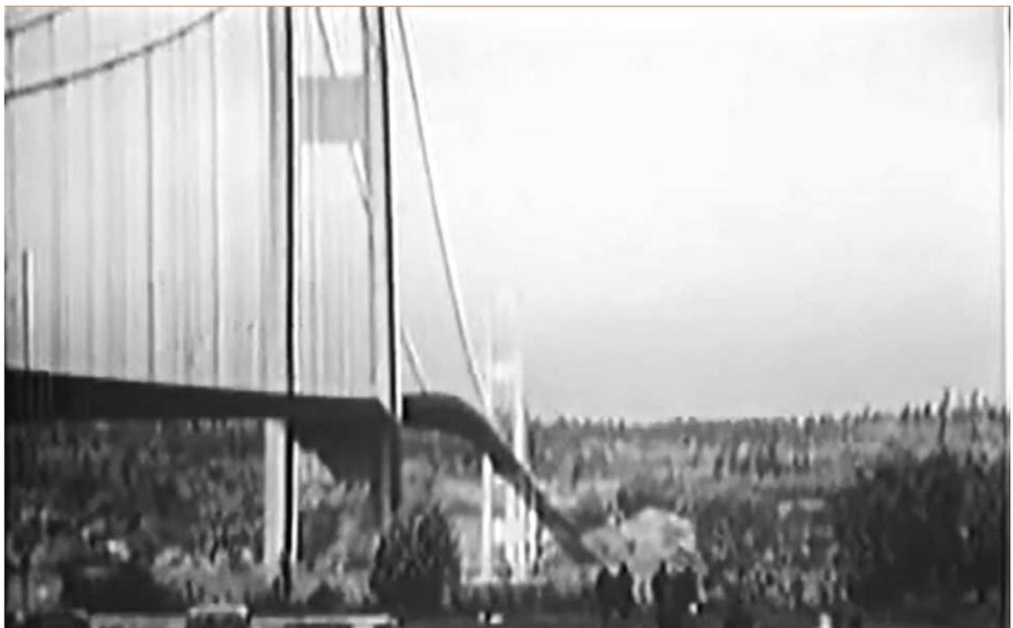
**Figura 1 - Início do efeito da ressonância da estrutura com o vento.**
