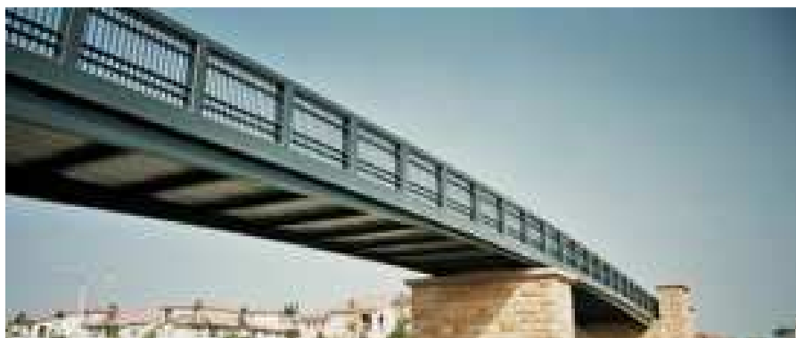
Figura 5 – Ponte utilizando estrutura tipo Vierendeel [16].
