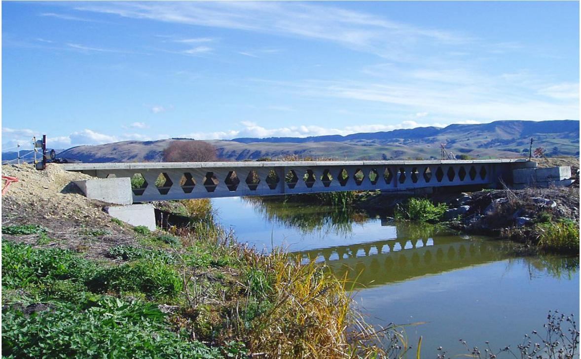
Figura 5 – Viga castelada aplicada em ponte [5]
